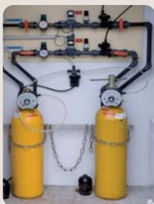
Les principaux traitements sont la déferrisation (élimination du fer dissout dans l'eau grâce à l'air qui permet l'oxydation du fer) et la chloration (élimination des bactéries grâce au chlore gazeux) et
